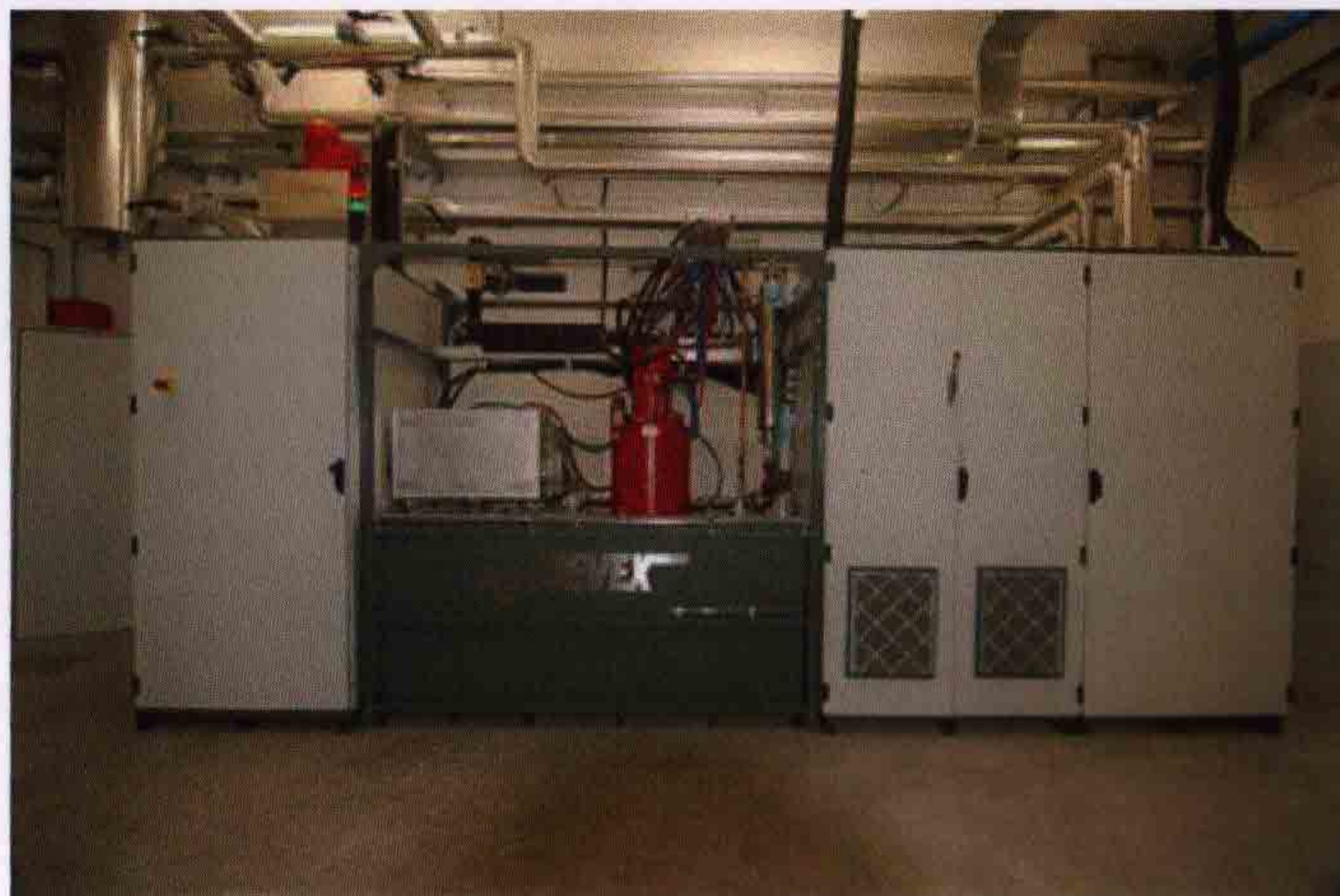
应用在辐照加速器上的高功率速调管
